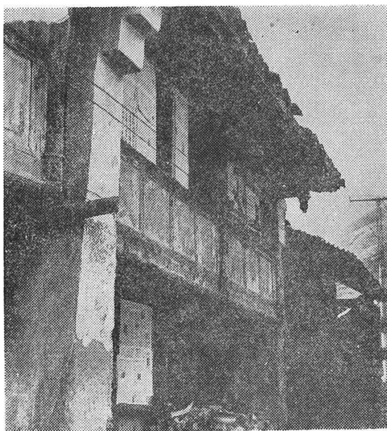
中共大金省委在绥靖正街的旧址（现金川镇老街李兆惠住房）（图八）
